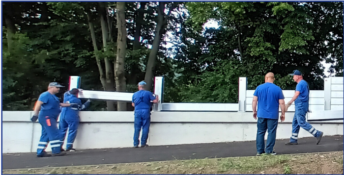
Ugradnja horizontalnih elemenata
