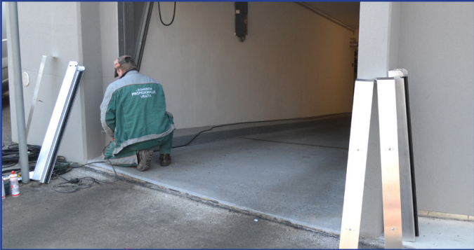
Ugradnja bočnih vodilica
